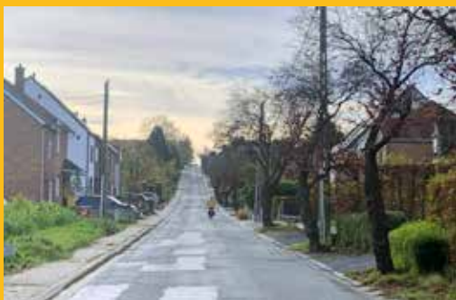
▲ De Lange Lostraat in Pellenberg maken we in samenwerking met de stad Leuven veiliger om te fietsen en te wandelen. Het wegdek zal volledig vernieuwd worden.
