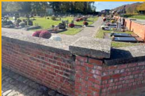
▲ Met de steun van Onroerend Erfgoed restaureren we de volledige kerkhofmuur in Linden, van het rondpunt tot in het centrum.
